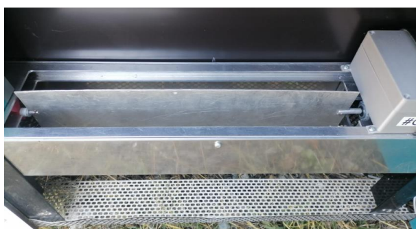
Prvky pro řízení průtoku vzduchu větranou mezerou – fasádní klapka a ventilátor
