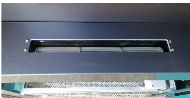
Prvky pro řízení průtoku vzduchu větranou mezerou – fasádní klapka a ventilátor
